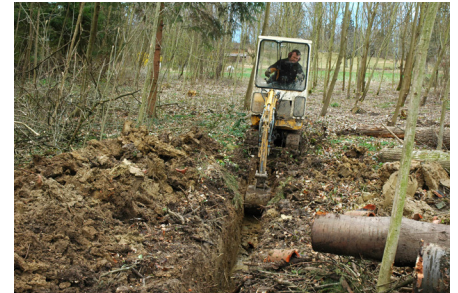
Freilegen eines eingedolten Quellbachs
